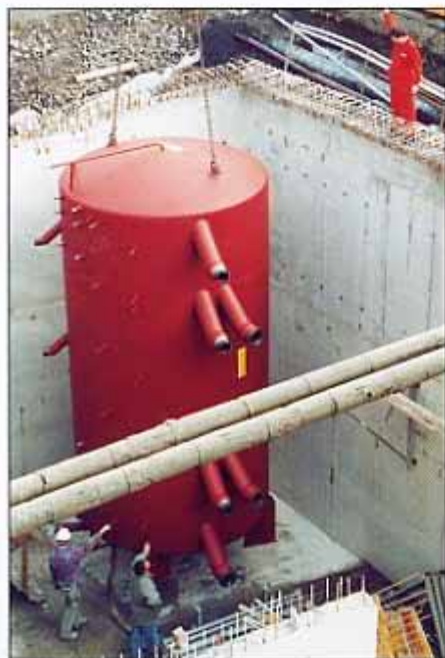
Grossspeicher werden am Stück eingebracht. In vielen Fällen ist eine Teillieferung mit Platzschweissung sinnvoll.
